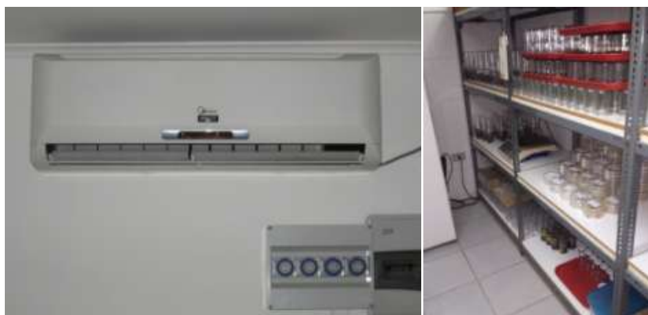
Foto 5.6.3 (izq). Sistema "Split" y controles. Foto 5.6.4 (der). Pieza de cultivo cuya temperatura fue mantenida a 20 °C con un sistema "Split"; placas Petri al centro derecha.
